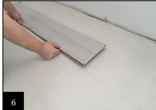
Pour garantir une pose à angle droit, nous vous recommandons de compléter (7) les deux premières rangées en respectant le décalage des joints d'extrémité prescrit d'au moins 30 cm. Veillez à faire coïncider les raccords d'extrémité avec rainure et languette et actionnez le verrouillage en exerçant une légère pression jusqu'à l'insertion complète (8).
